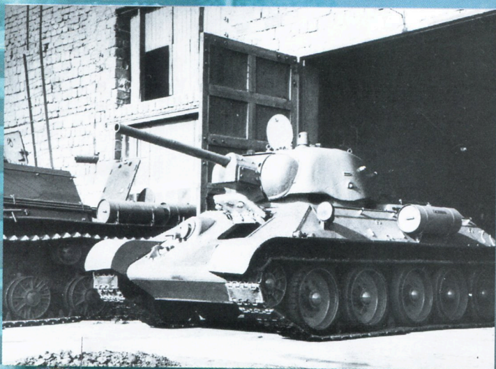
★ Танк Т-34 со штампованной башней производства УЗТМ покидает сборочный цех Челябинского Кировского завода, август 1943 года.
