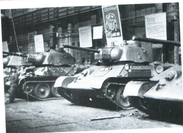
★ Танки Т-34 обр. 1942 г. со штампованными башнями и командирскими башенками в цеху Челябинского Кировского завода. Октябрь 1943 года.
